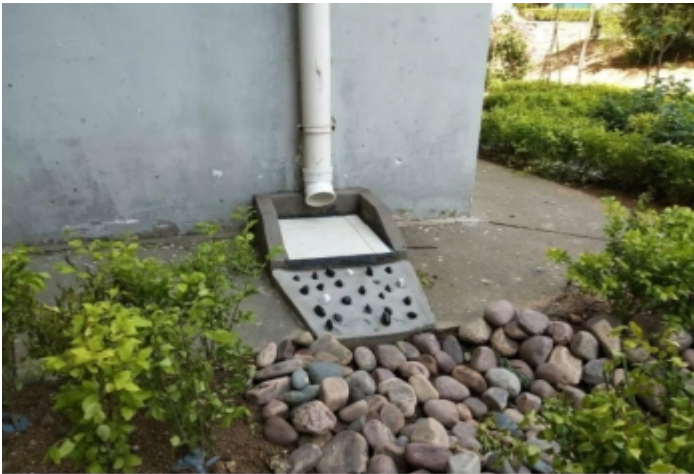
屋面雨水断接示意图
